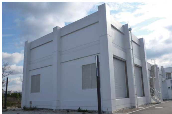
写真4：建て替えられた変電所
