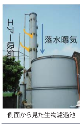
図2:ベトナム農村部に設置した地下水中砒素除去の実用プラント
