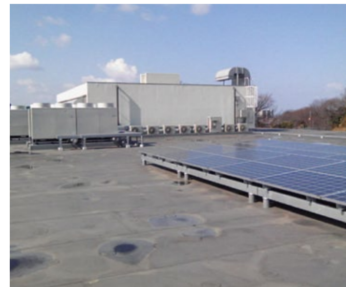
図2 全面改装された屋上。手前に太陽光パネル、奥に大型除湿器用室外機と二階機械室が見えている。
