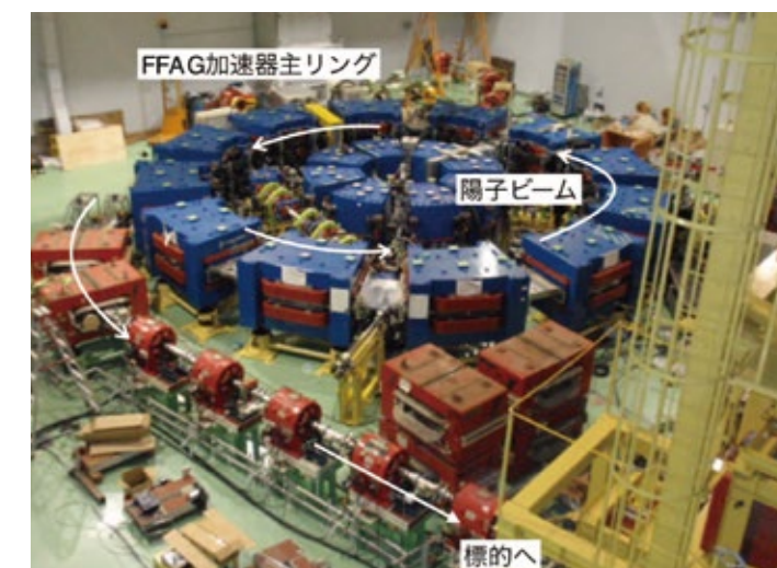
図. FFAG加速器全景。直径約10メートルの主リング中を陽子ビームが周回しながら加速される。
