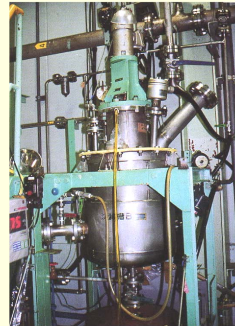
転換試験棟 沈殿槽
