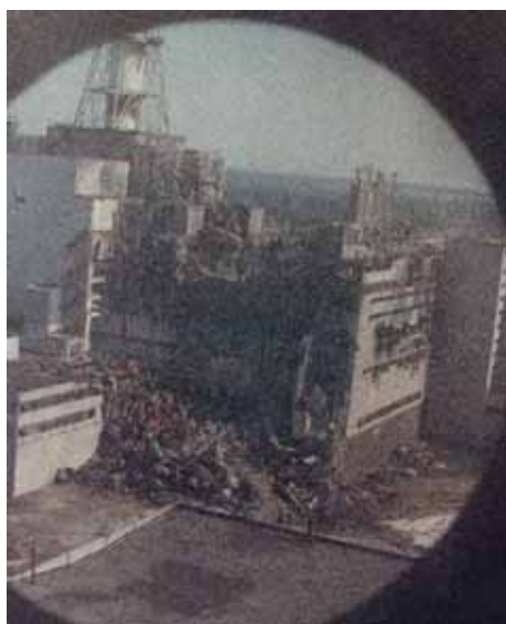
図3. 破壊された4号炉.
