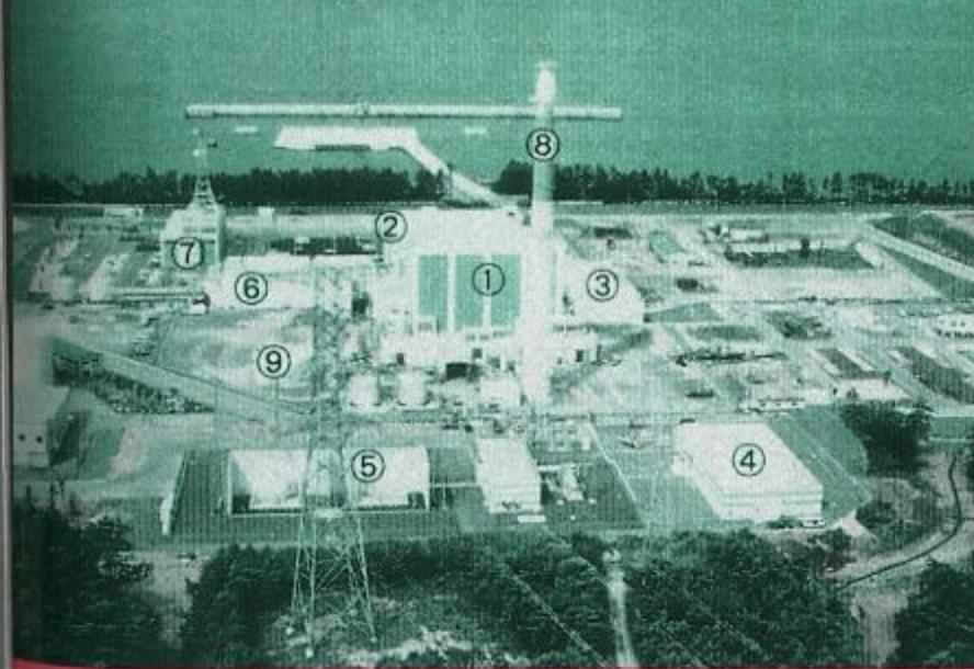
①原子炉建屋 ②タービン建屋 ③サービス建屋 ④固体廃棄物貯蔵庫 ⑤開閉所
