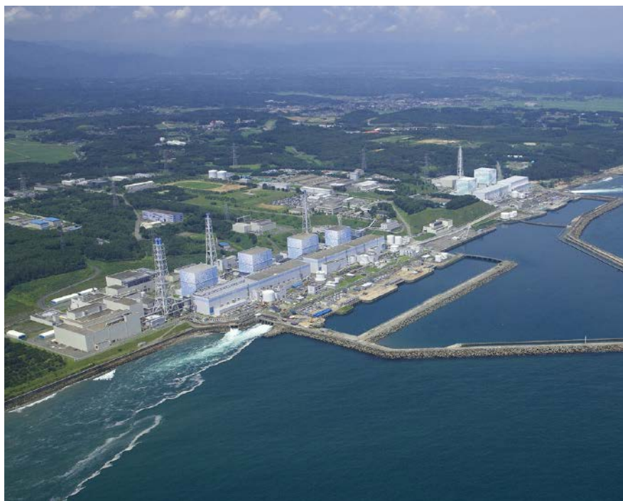
在りし日の東京電力福島第1原子力発電所。手前から、4号機、3号機、2号機、1号機。少しおいて5号機、6号機。四角い建物が原子炉建屋で、長細いのがタービン建屋。非常用ディーゼル発電機はタービン建屋の地下に設置されていた 写真：東京電力ホームページより
