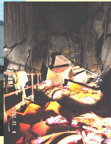
循環ポンプ室
