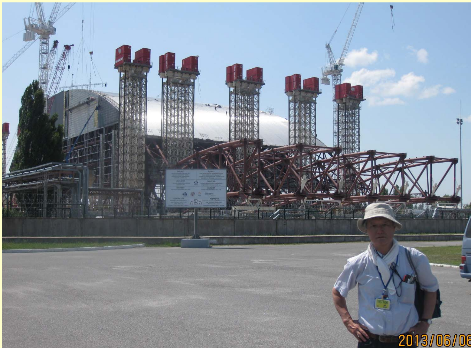
2013年6月 新シェルター建設現場
