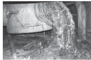
図9 空っぽだった炉心(上)と溶岩状になって流れ落ちた核燃料(下)
