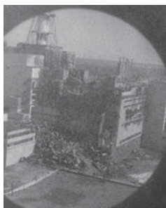
写真2 破壊された4号炉
