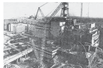
写真3 建設中の石棺
