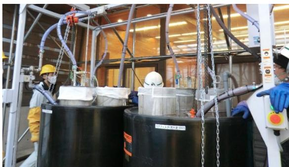
図 2 汚染水ろ過システムの外観 右手前のステンレス容器では大きな粒子を取り除き、左奥の容器で放射性セシウムを除去する
