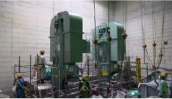
4号機ポンプ室内 (ポンプ設置作業中)
