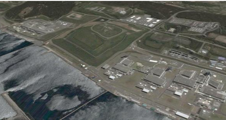
柏崎刈羽NPP (7 基/1 サイト)
