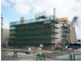
4号機防水構造 新設ポンプ室(設置作業中)
