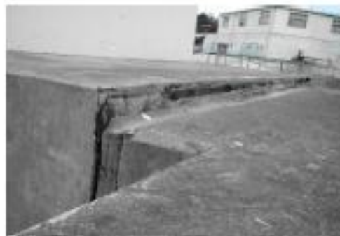
排気塔と共同溝のずれ
