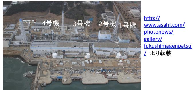
3月30日撮影:2号機を残して原子炉建家破損
