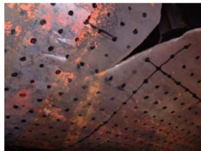
④ き裂停止部 (下流側から観察)
