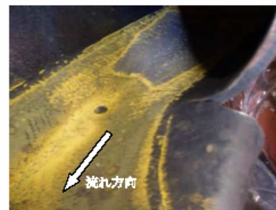
⑦-1 ドレン穴周辺
