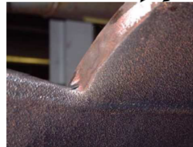
⑤ き裂停止部 (上流側・内面側から観察)
