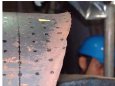
② 配管破損部 (下流側から観察)
