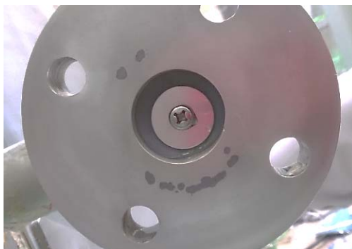
写真8 SP1系アルミフランジ補修後
