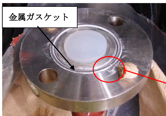
写真3 漏洩箇所のステンレス製フランジ
