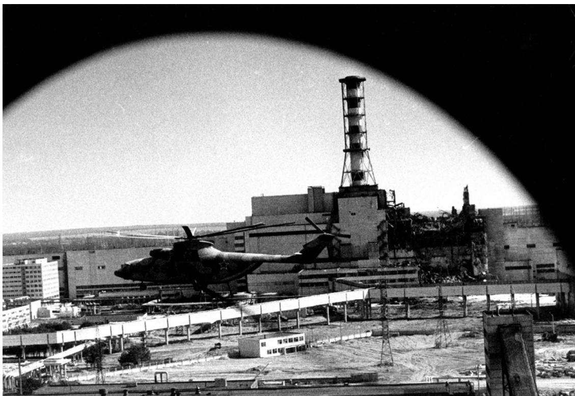
事故直後の数日間、日が照っている間中、大型の軍用ヘリコプターがチェルノブイリ原発周辺を飛び回り、原発敷地の全体に特殊な粘着性の溶液を散布した。この溶液は、敷地内のいたるところを覆っていた放射性的のほこりを吸着した。 撮影・イーゴリ・コスティン
