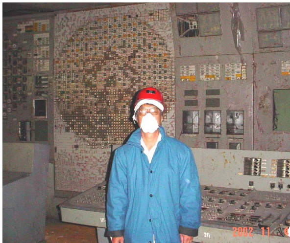
図9. 4号炉制御室(2002年11月)
