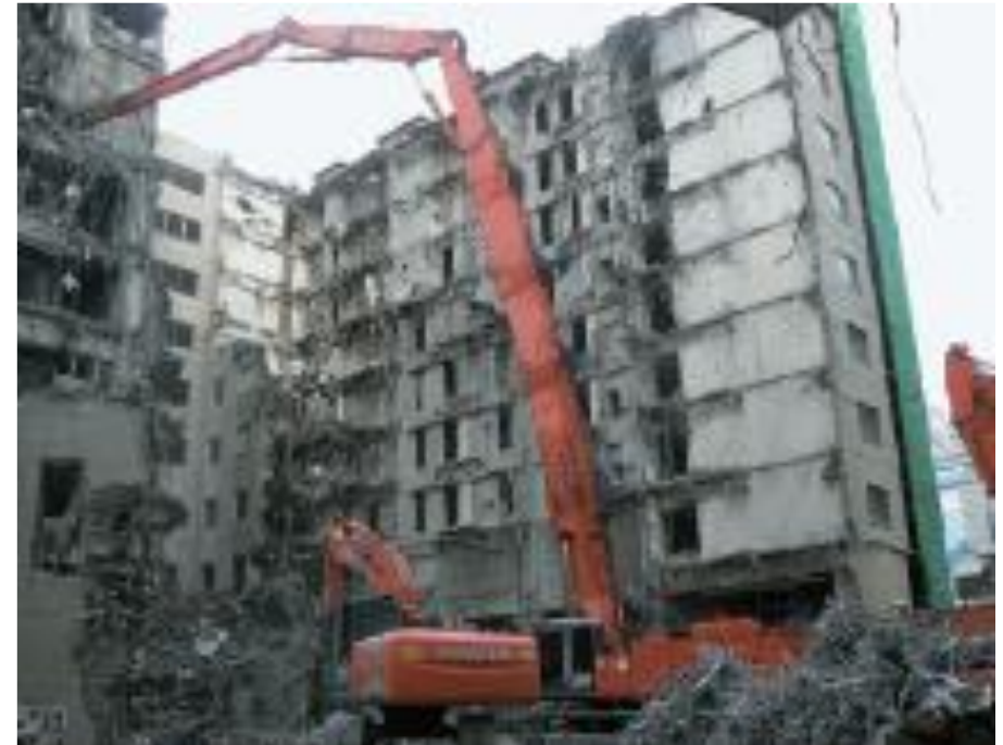
図 RC造の解体工事の状況
