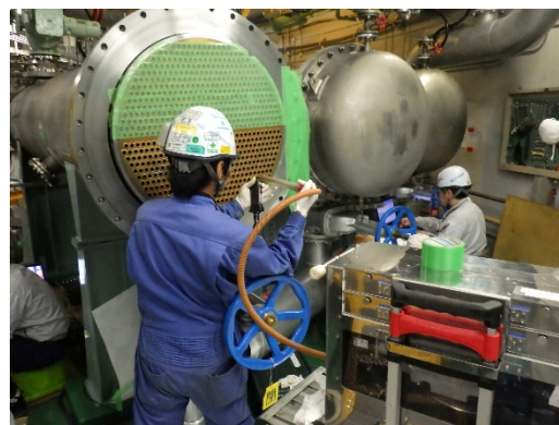
図.2 渦流探傷検査作業風景
