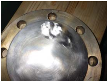
閉止フランジの補修
