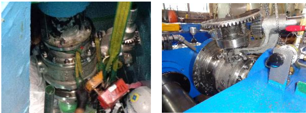
図5 燃料輸送管ボールバルブ取外し・耐圧検査の様子
