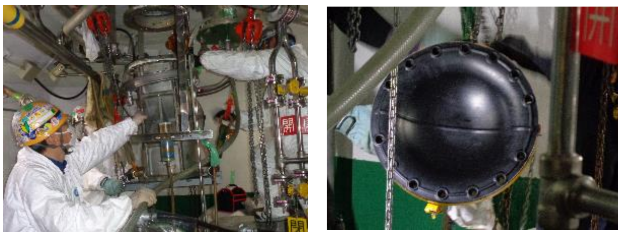
図4 主閉鎖弁取り外し・分解点検の様子
