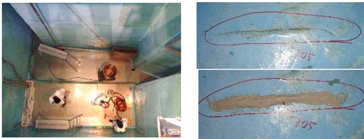
図6 SFP 清掃の様子・塗装面の補修例
