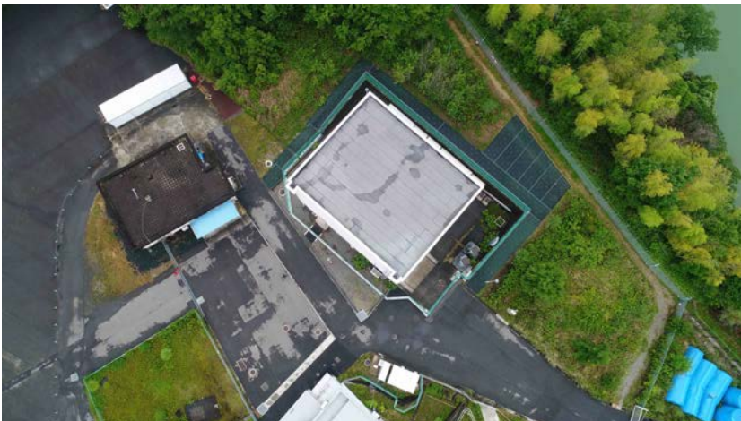
写真2 使用済燃料室屋上点検時のドローンカメラ画像
