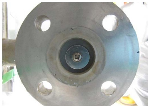
写真7 SP1系アルミフランジ補修前
