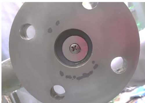
写真8 SP1系アルミフランジ補修後
