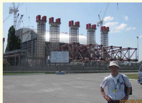
チェルノブイリ新石棺建設現場
