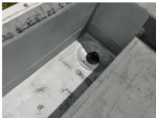
図 7 屋上防水シート補修
