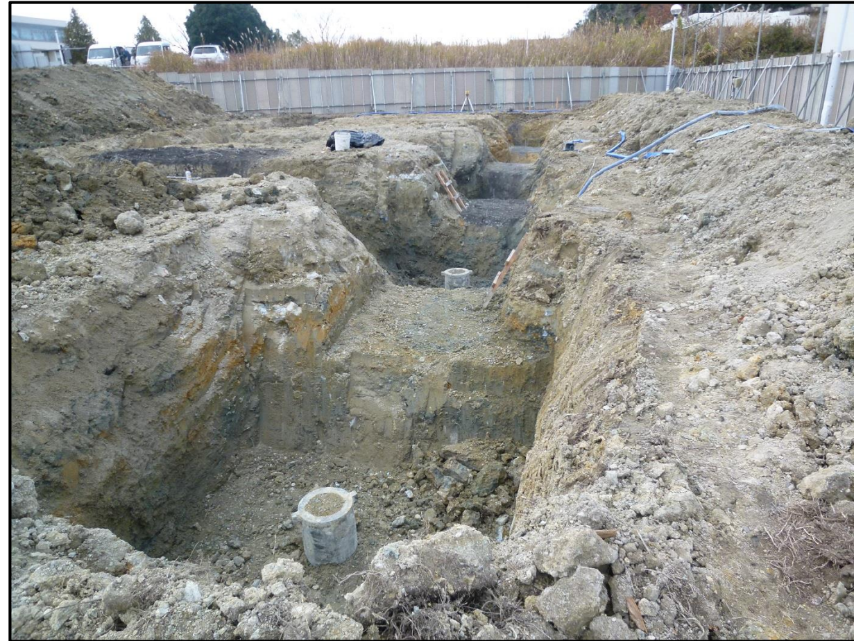
○基礎、基礎梁部分の掘削
