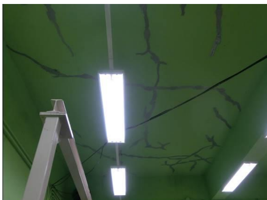
図 6 天井薬剤注入
