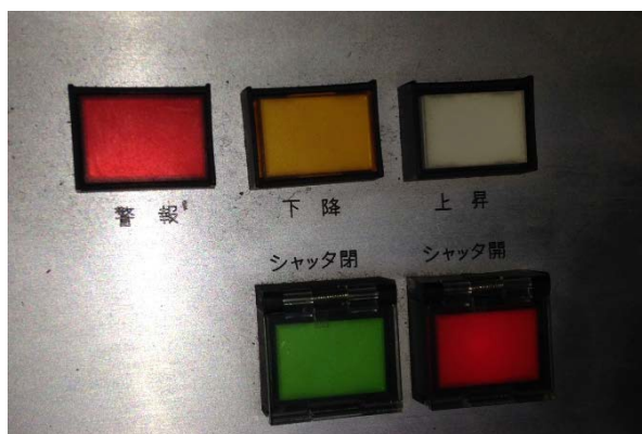
写真4. シャッター制御システム
