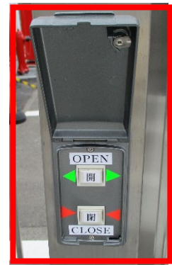
車両専用ゲート自動開閉操作盤
