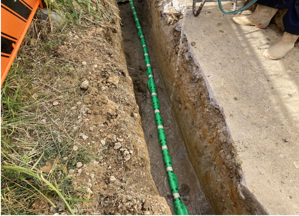
写真説明：工作棟 ガス埋設配管施工の状況
