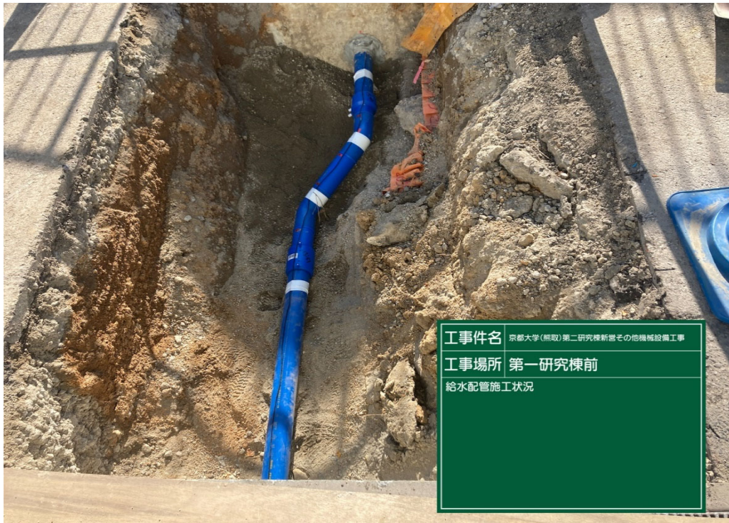
写真説明：第一研究棟 給水埋設配管施工の状況
