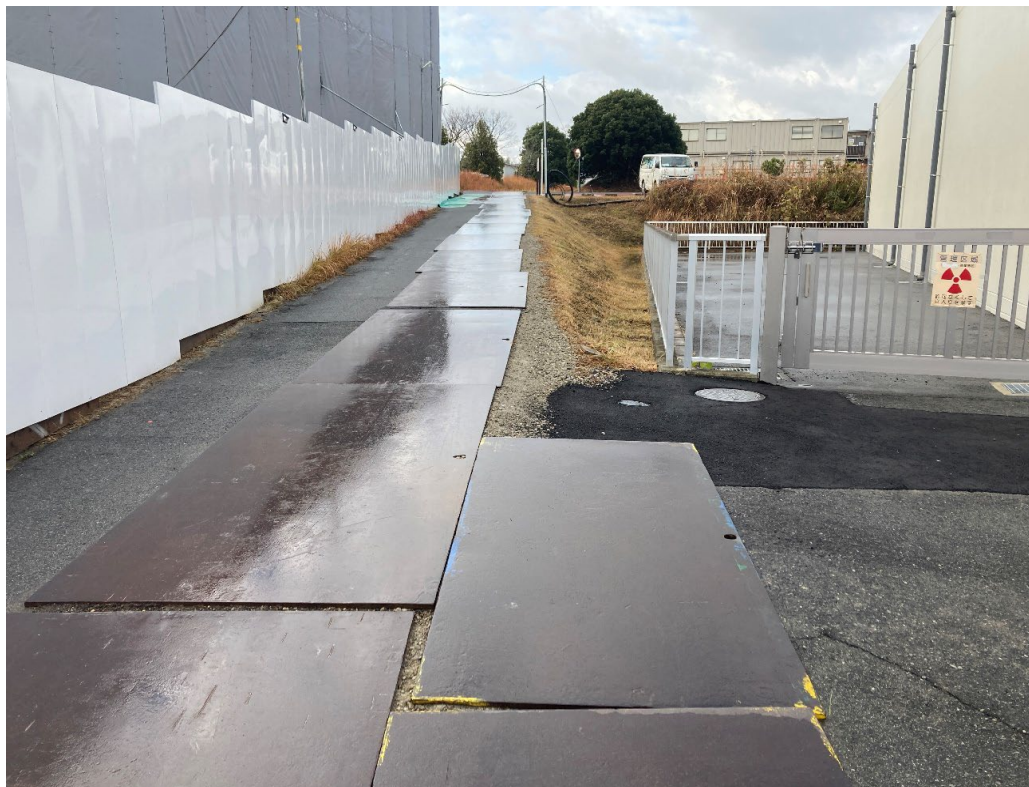
写真説明: 汚染物貯蔵庫 南
