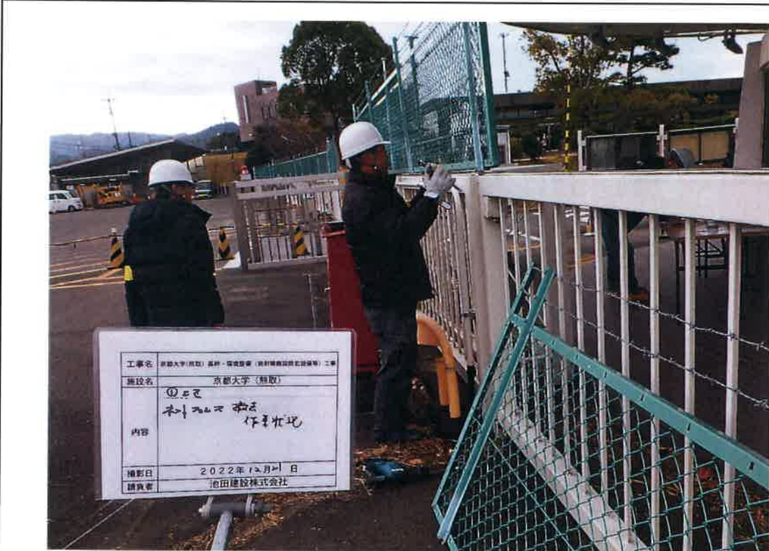
写真説明：①工区 ネットフェンス撤去作業状況
