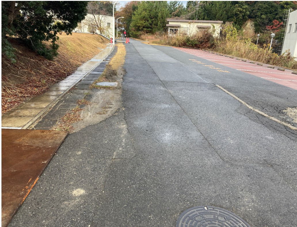
写真説明: ガンマ棟東
