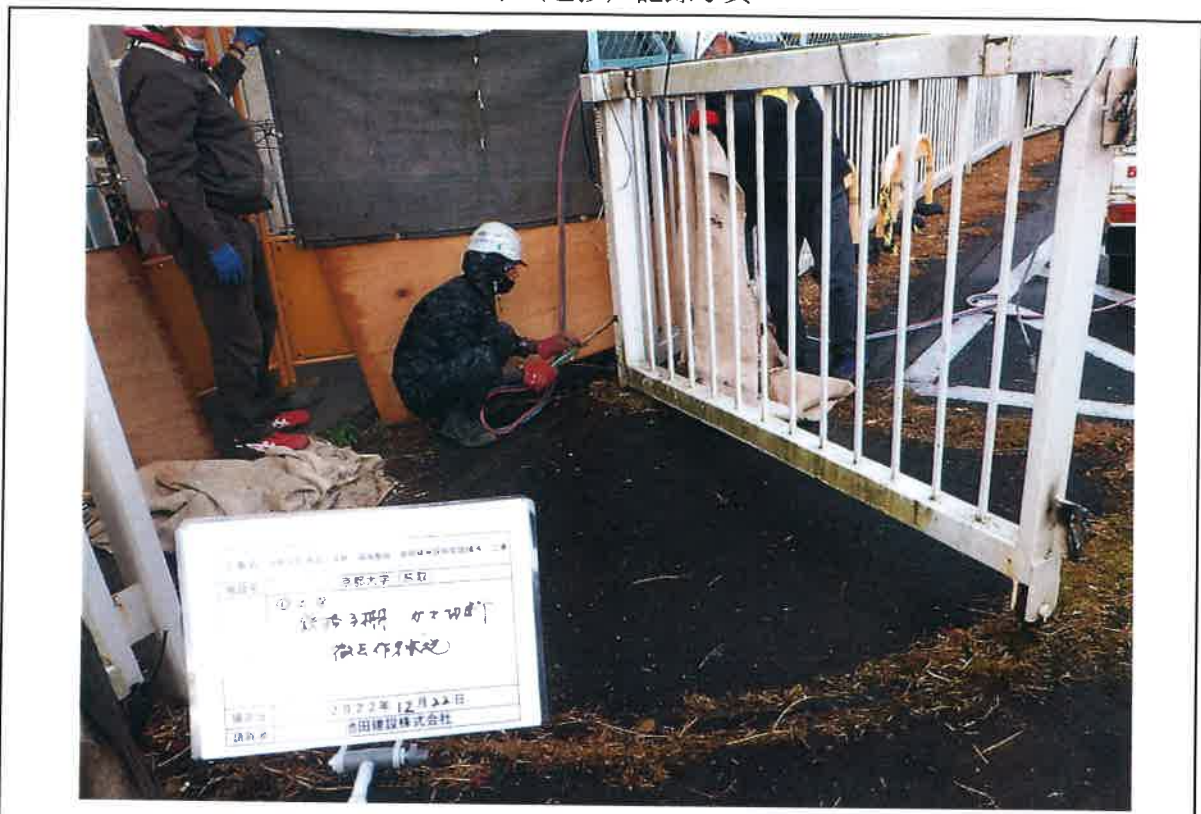
写真説明：①工区鉄格子柵ガス切断撤去作業状況 令和 4年12月22日 撮影
