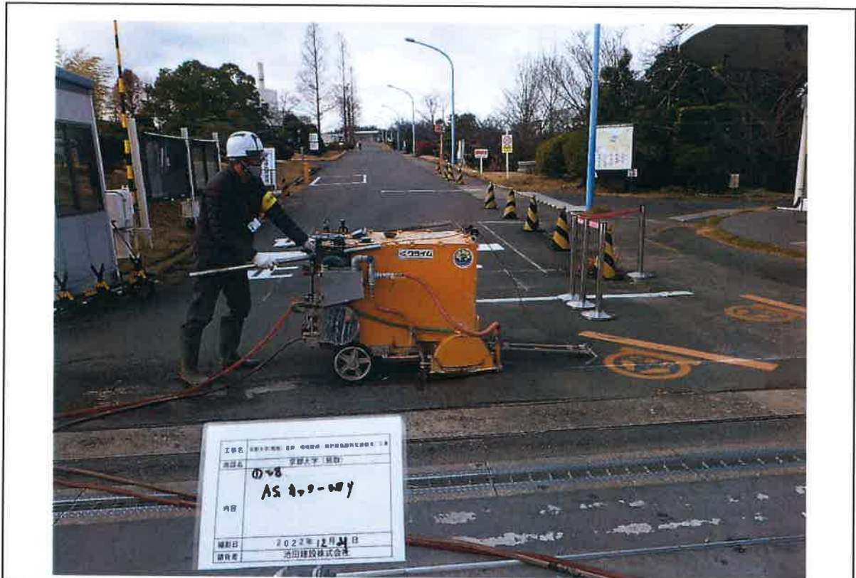
写真説明：正面入口舗装版カッター入作業状況
