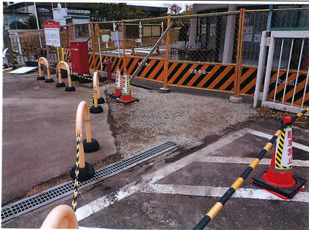
写真説明：駐車場側舗装版撤去後碎石RC-40敷設
