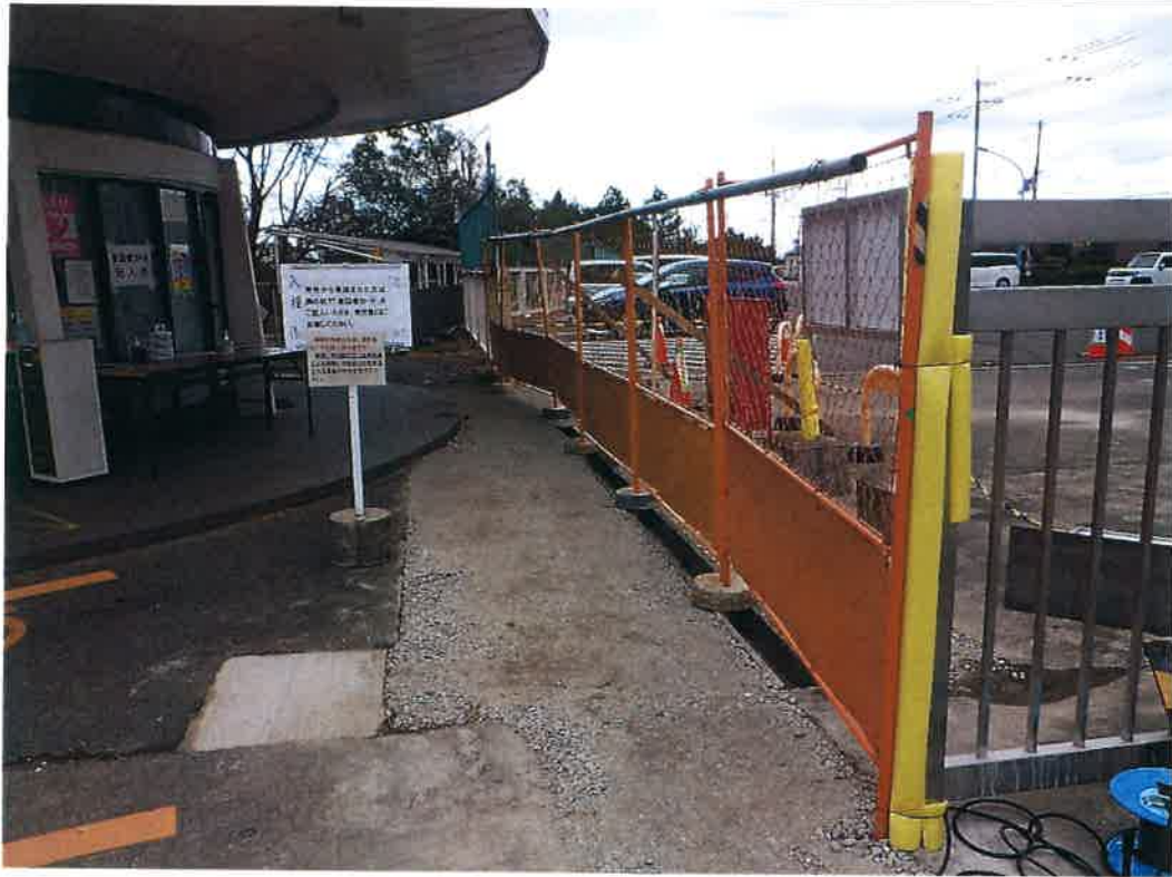
写真説明：守衛室前舗装版撤去後碎石RC40敷設
