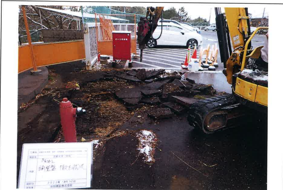
写真説明：①工区AS舗装版撤去作業状況 令和 4年12月 23日 撮影
