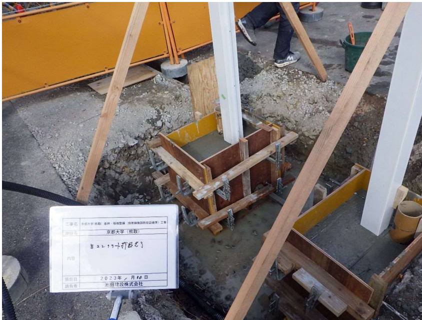
門扉基礎生コン打設
