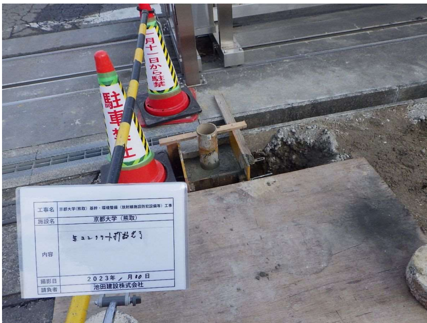
フェンス基礎生コン打設
