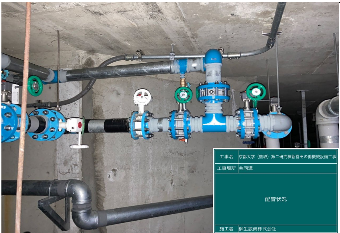
写真説明：共同溝内 給水配管状況
