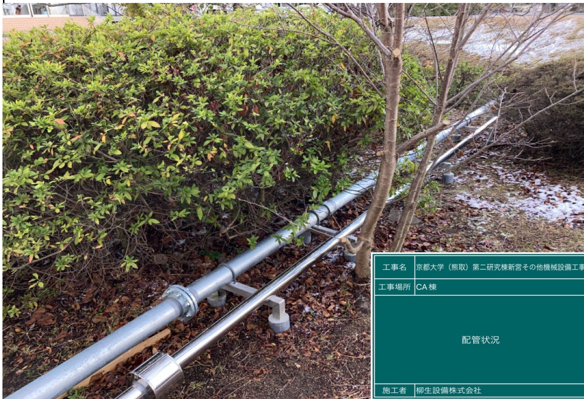
写真説明：1月 基幹工事 CA棟露出配管状況
