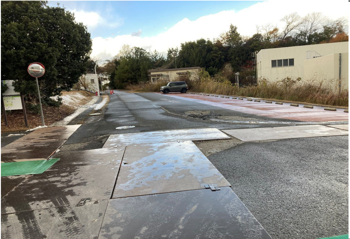
写真説明：第二研究棟前状況
