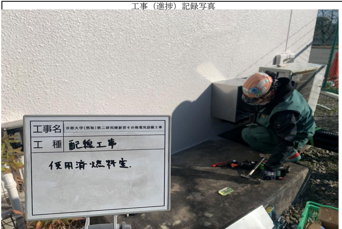
写真説明：使用済燃料室 配線ルート構築
