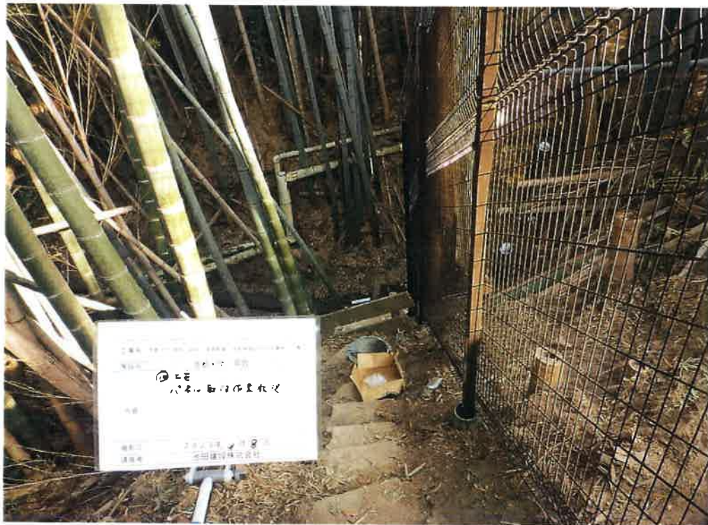
写真説明：⑪工区パネル取付状況
