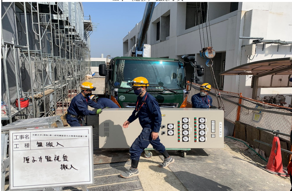
写真説明：原子力監視設備監視機器搬入
