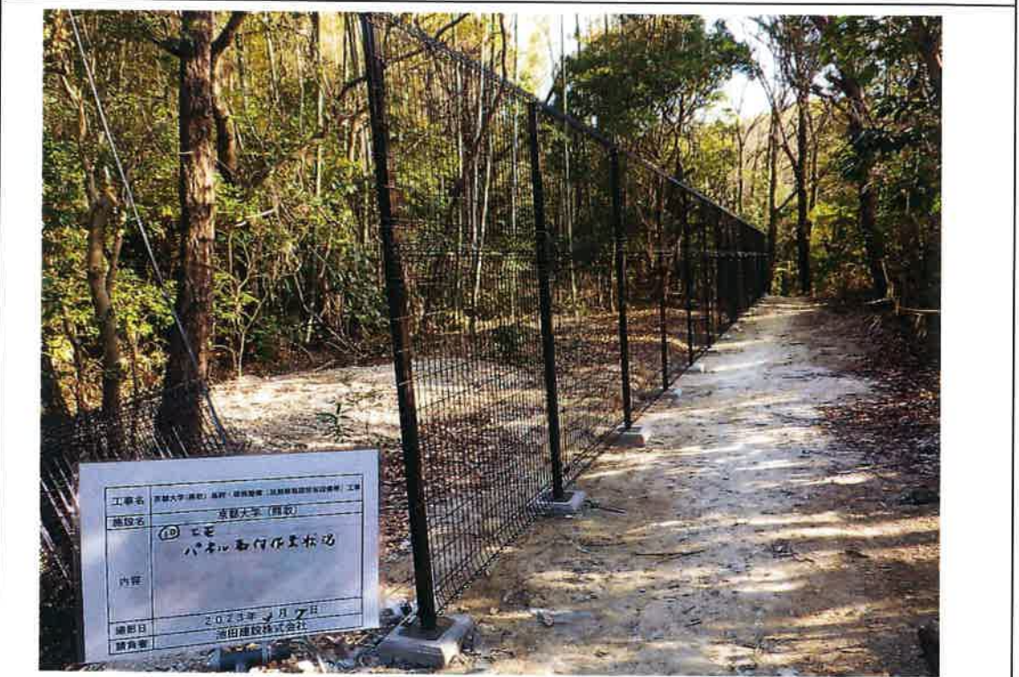
写真説明:⑩工区パネル取付状況
