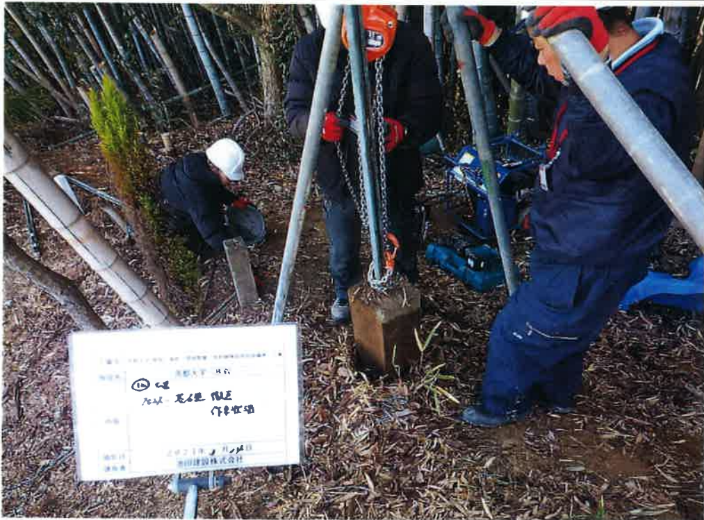
写真説明⑫工区基礎撤去状況（ゴルフ場隣接）
