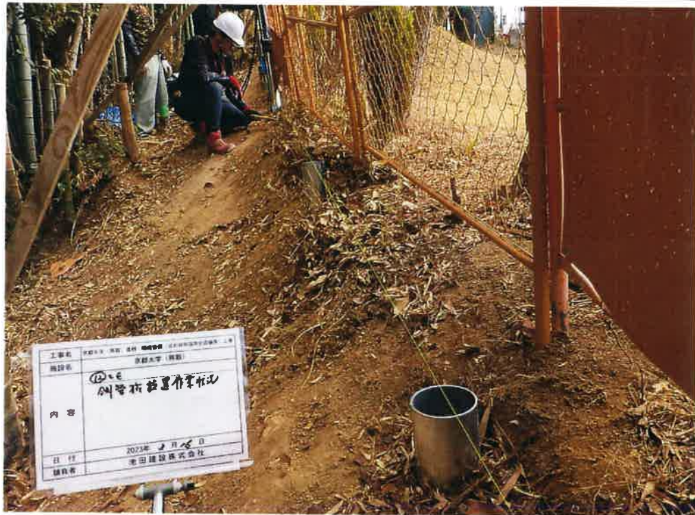
写真説明：⑫工区鋼管杭設置状況（ゴルフ場隣接）
