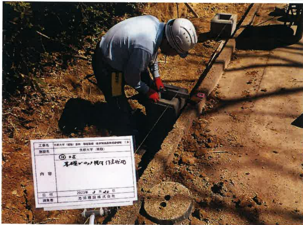
写真説明：⑬工区基礎ブロック据付作業状況
