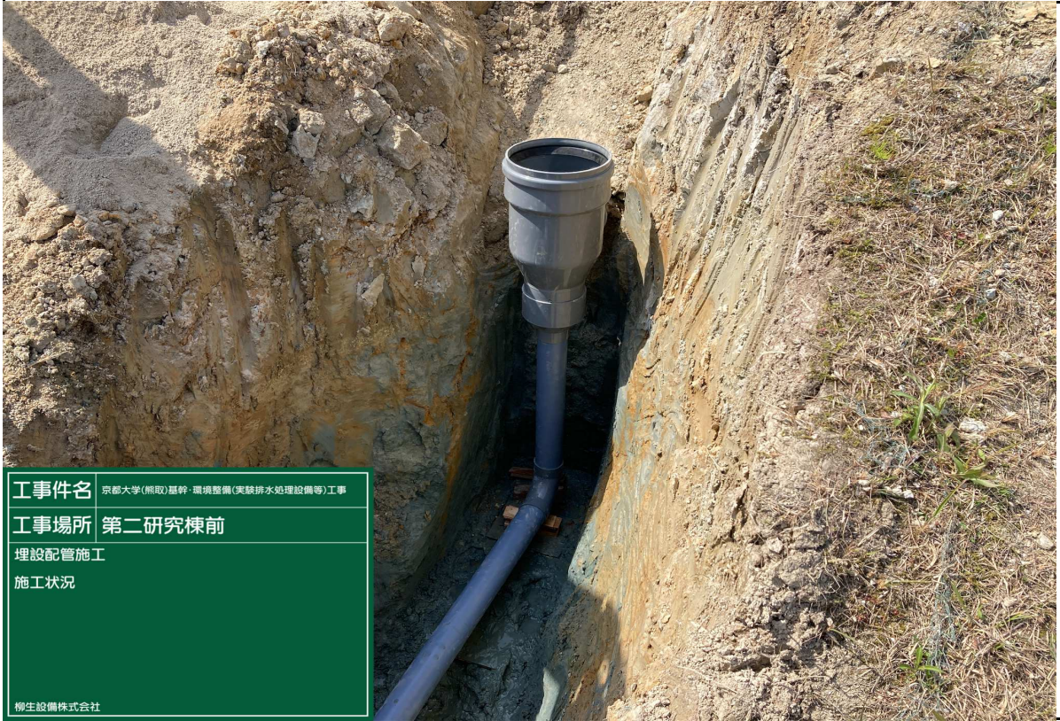
写真説明：第二研究棟前 配管敷設状況
