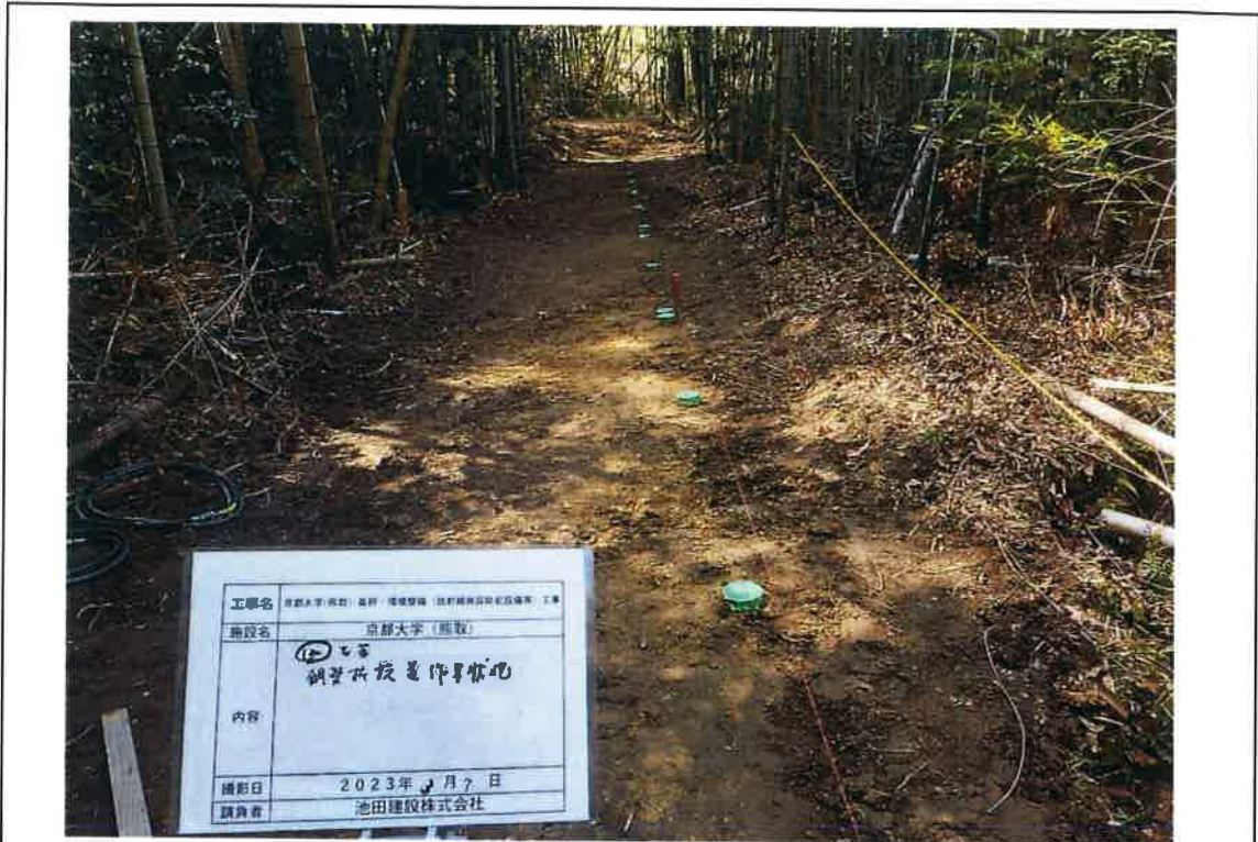
写真説明:⑫工区鋼管杭設置状況
