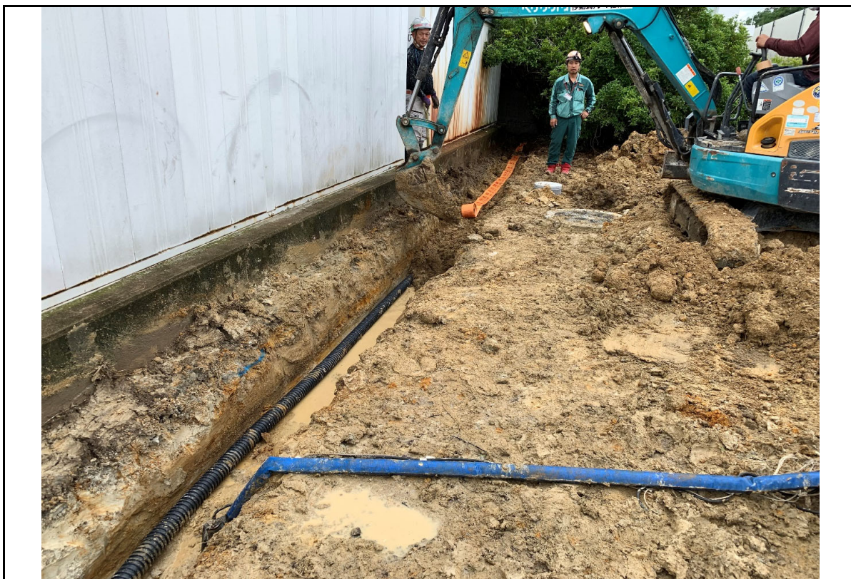
写真説明：環境放射能分析測定室埋設配管工事
