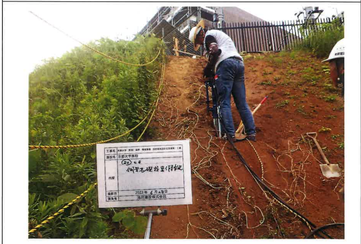
写真説明：②工区鋼管杭設置作業状況
