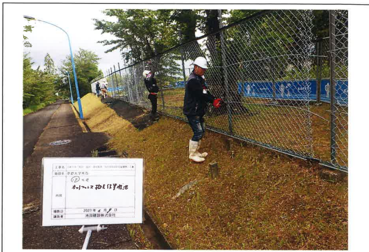
写真説明⑱工区ネットフェンス撤去作業状況
