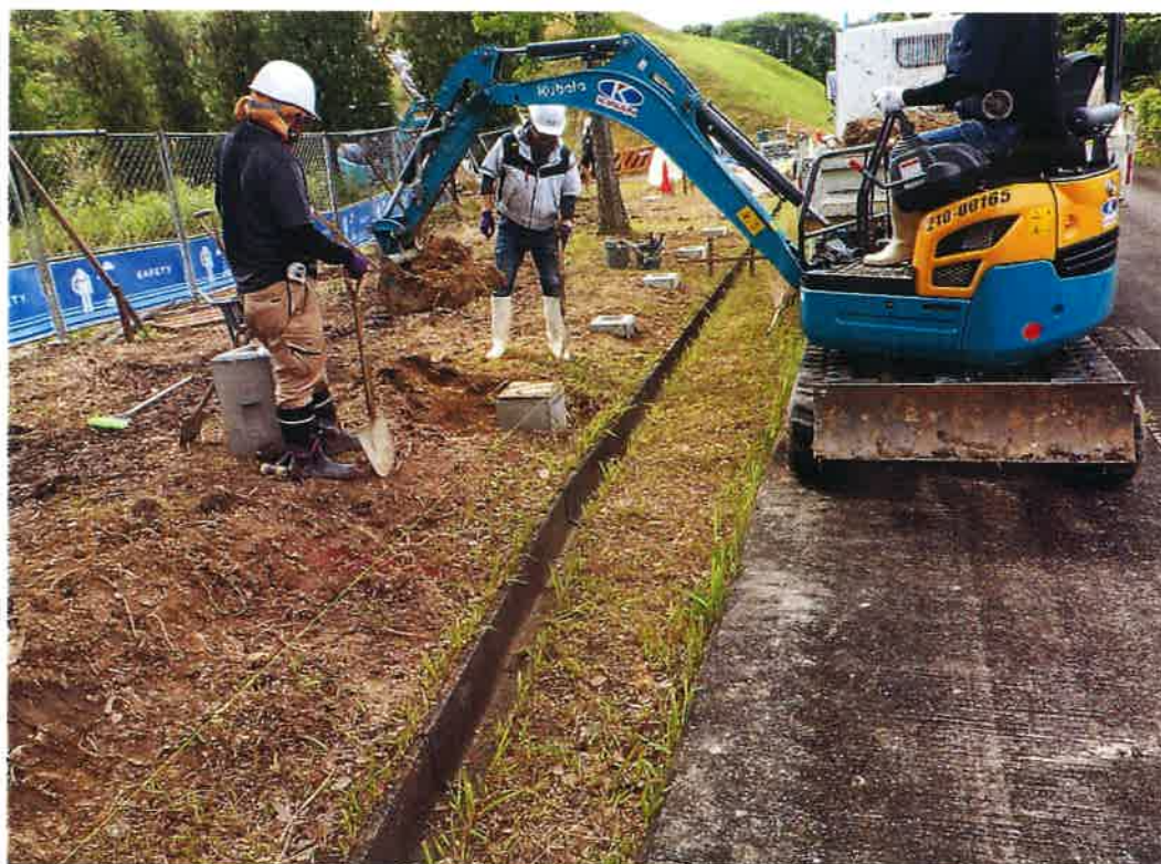
写真説明:⑲工区基礎ブロック設置作業状況
