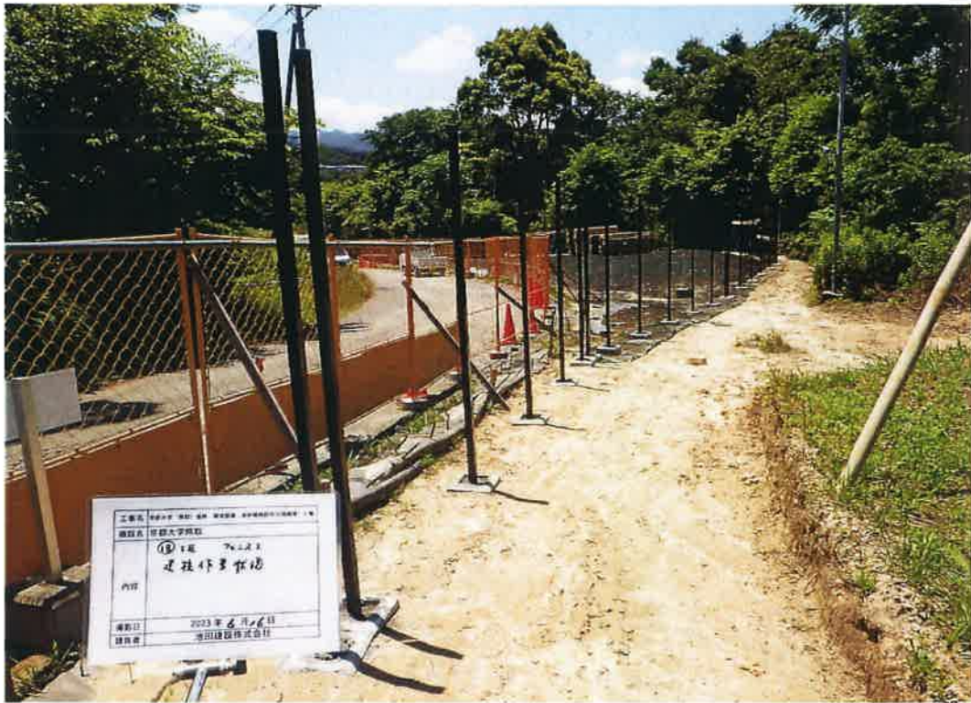
写真説明：⑮工区建柱作業状況
