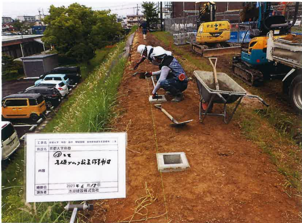
写真説明:①工区基礎ブロック設置作業状況
