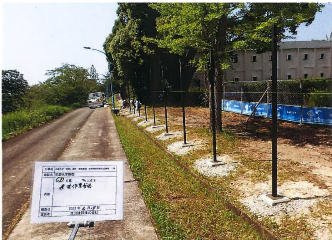
写真説明：⑯工区建柱作業状況
