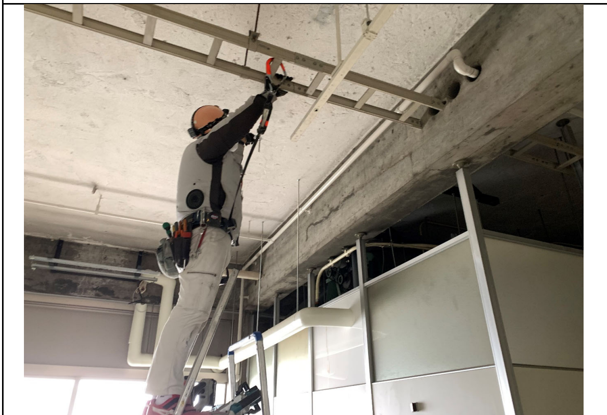
写真説明：第一研究棟 1 階 器具撤去作業
