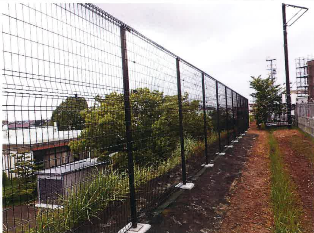
写真説明：⑬工区パネル設置
