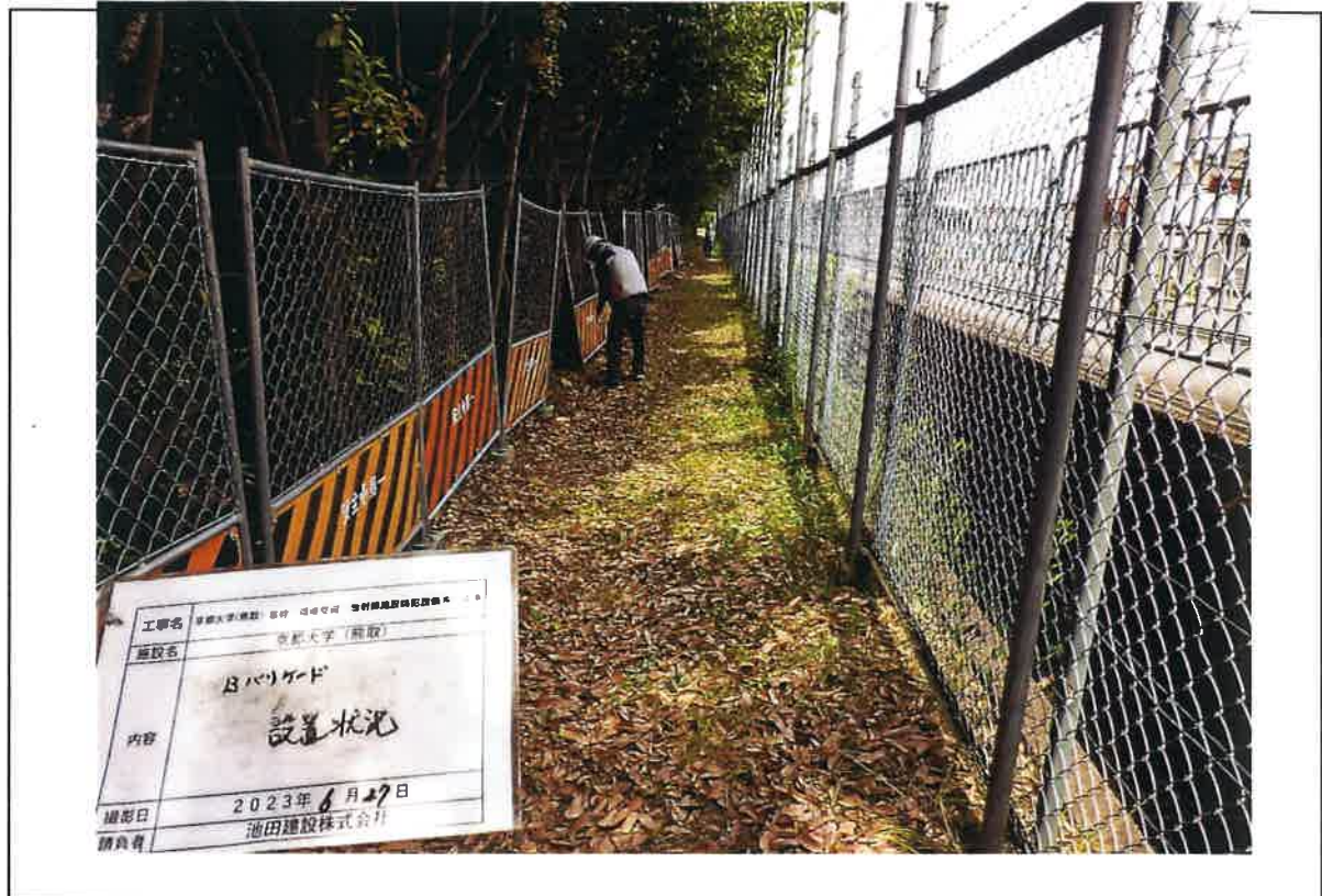
写真説明：②工区フェンスバリアード設置
