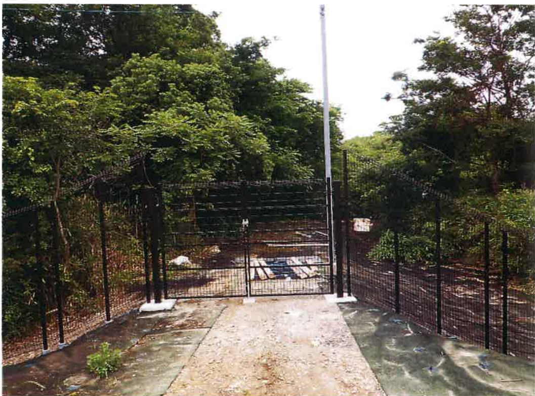
写真説明:①メッシュフェンス門扉設置完了
