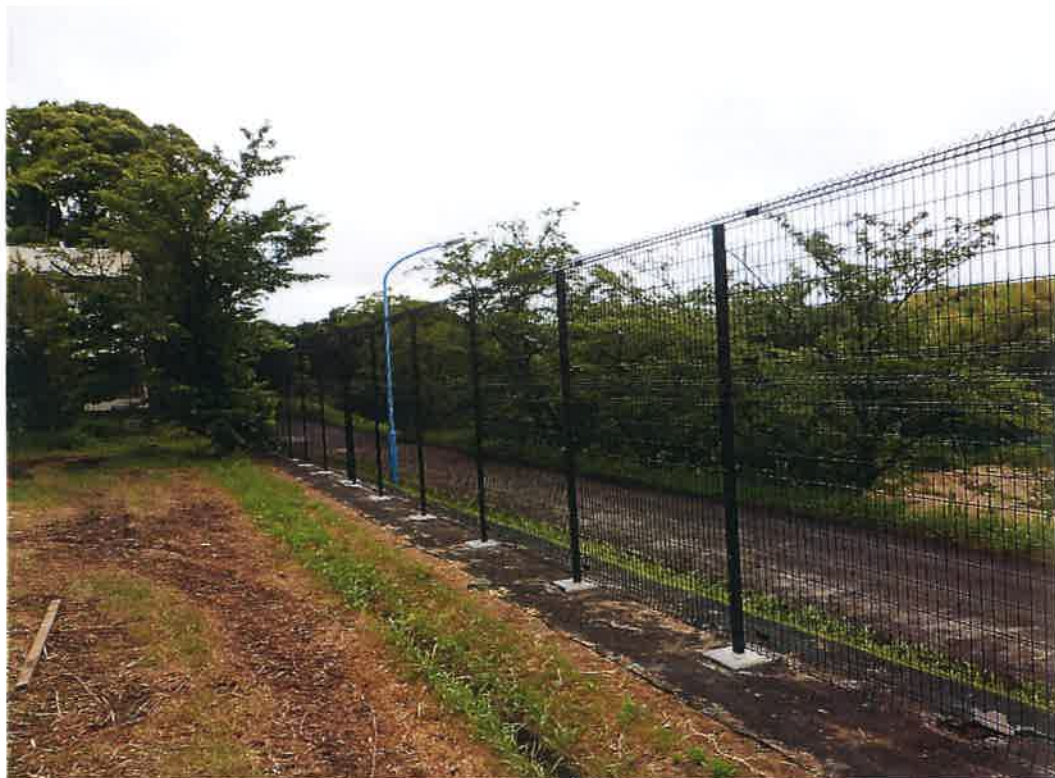
写真説明：⑬工区パネル設置
