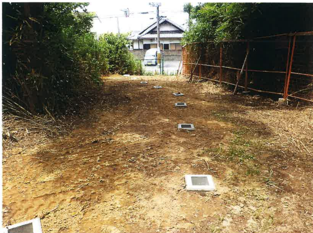
写真説明：⑦工区基礎ブロック設置完了
