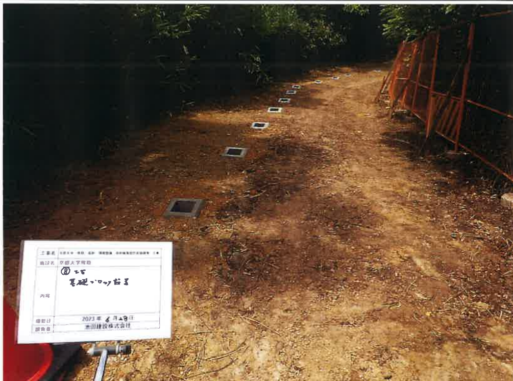
写真説明：⑧工区基礎ブロック設置完了
