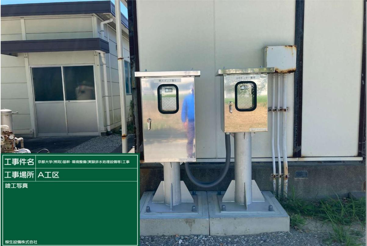
写真説明：A工区 PH8 排水・モニタ盤
